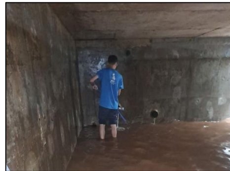
รูปที่ 2-23 การล้างทำความสะอาดถังเก็บน้ำสำรอง
