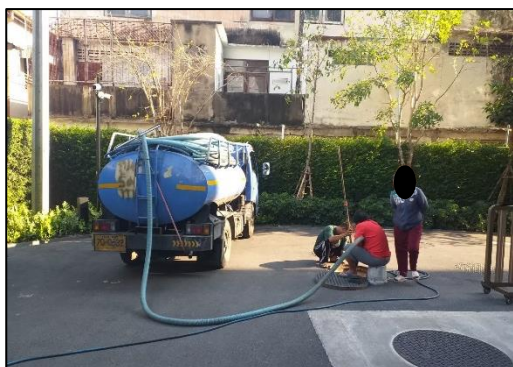
รูปที่ 2-15 การสูบกากไขมัน
