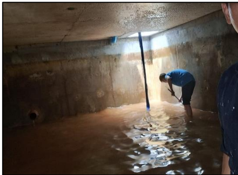
รูปที่ 2-23 การล้างทำความสะอาดถังเก็บน้ำสำรอง
